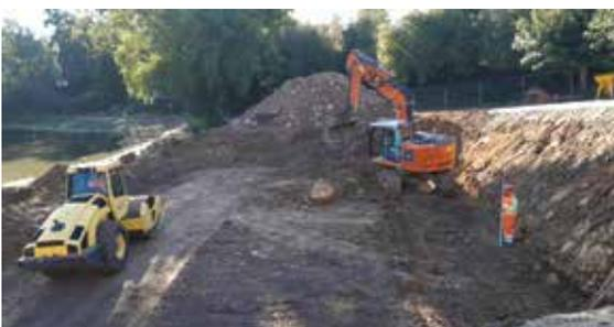
**Réservoir tampon (parking étang)** : réalisation d'un bassin tampon (réservoir de 450 m<sup>3</sup>) devant stocker les eaux usées et eaux pluviales en cas de forte pluie, évitant ainsi les rejets dans l'étang. La fin des travaux est prévue début 2024.
