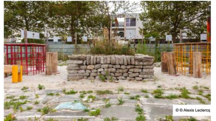
Une jardinière et une allée pavée à joints fertiles réalisées en béton issues de démolitions
